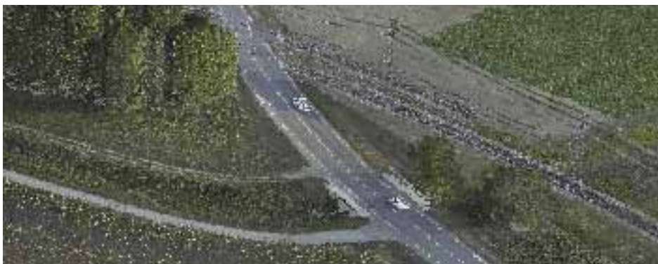
▲ Laserscan eines Trassenabschnittes bei Mistelbach
