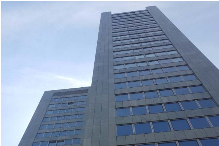
Unser neues Büro befindet sich im Ares Tower
